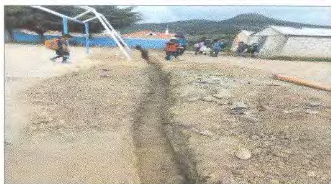
Foto 4: sustruccion de tuberia PVC linea principal de aguas negras
