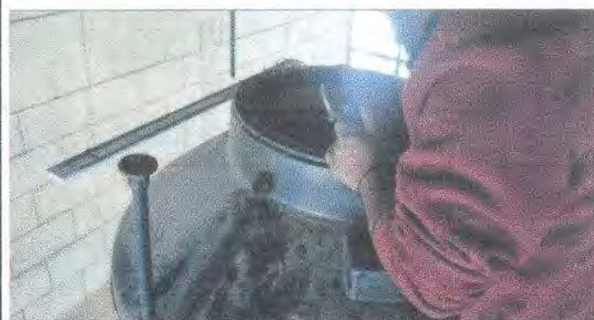
Foto 5: sustitucion de accesorios de deposito de agua
