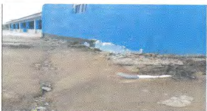
Foto 12: Introducción de 33 metros de drenaje a fosa de baños por pila instalada.
