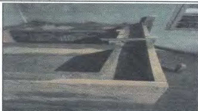
Foto 8: Sustrución de pila de cemento de dos lavaderos hecha a mano
