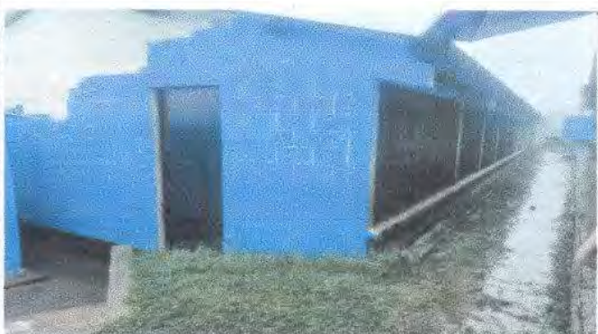
Foto 9: Aplicación de pintura en módulo II
