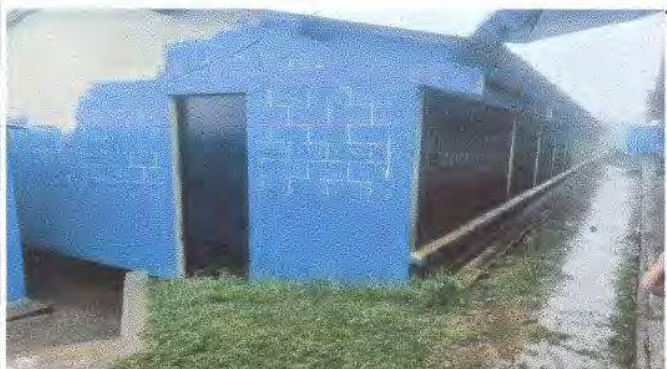
Foto 9: Aplicación de pintura en módulo II
