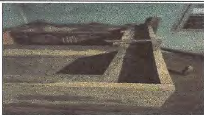
Foto 8: Sustrución de pila de cemento de dos lavaderos hecha a mano
