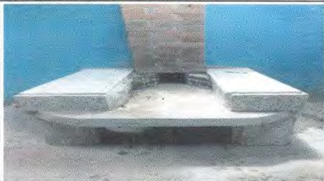
Foto 7: Sustrución de estufa rural (completa) incluye chimenea y plancha de metal.
