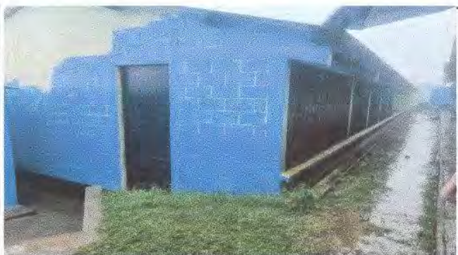
Foto 9: Aplicación de pintura en módulo II
