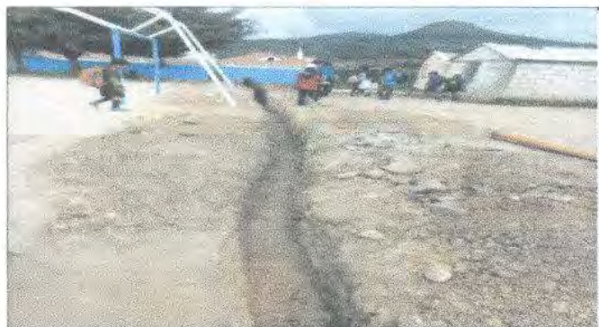
Foto 4: sustitucion de tubería PVC línea principal de aguas negras
