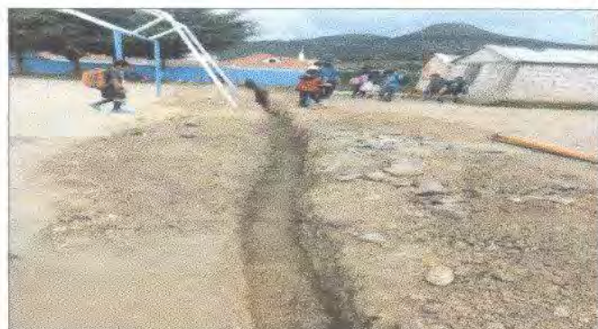
Foto 4: sustrucion de tuberia PVC linea principal de aguas negras
