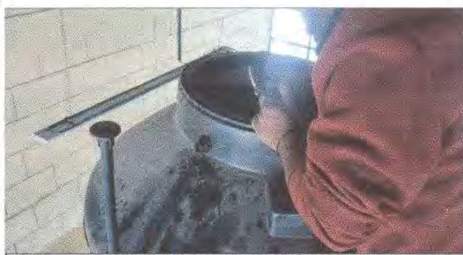
Foto 5: sustrucion de accesorios de deposito de agua
