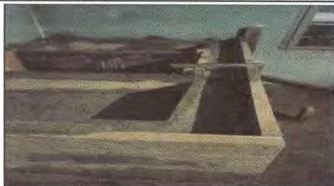
Foto 8: Sustrucción de pila de cemento de dos lavaderos hecha a mano
